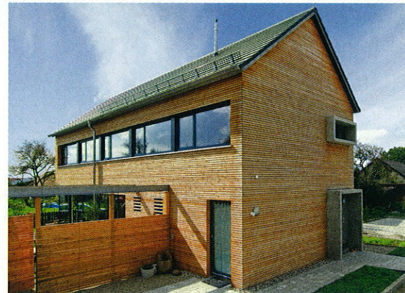
Hat nicht jeder: eine vergrauende Lärchen- verschalung als Fassade.
