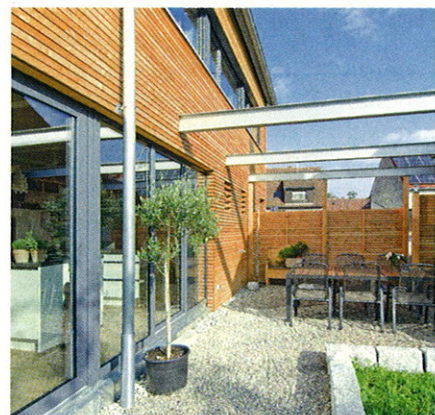
Später soll eine Überdachung des Sitzplatzes folgen, die Träger dafür sind schon da.
