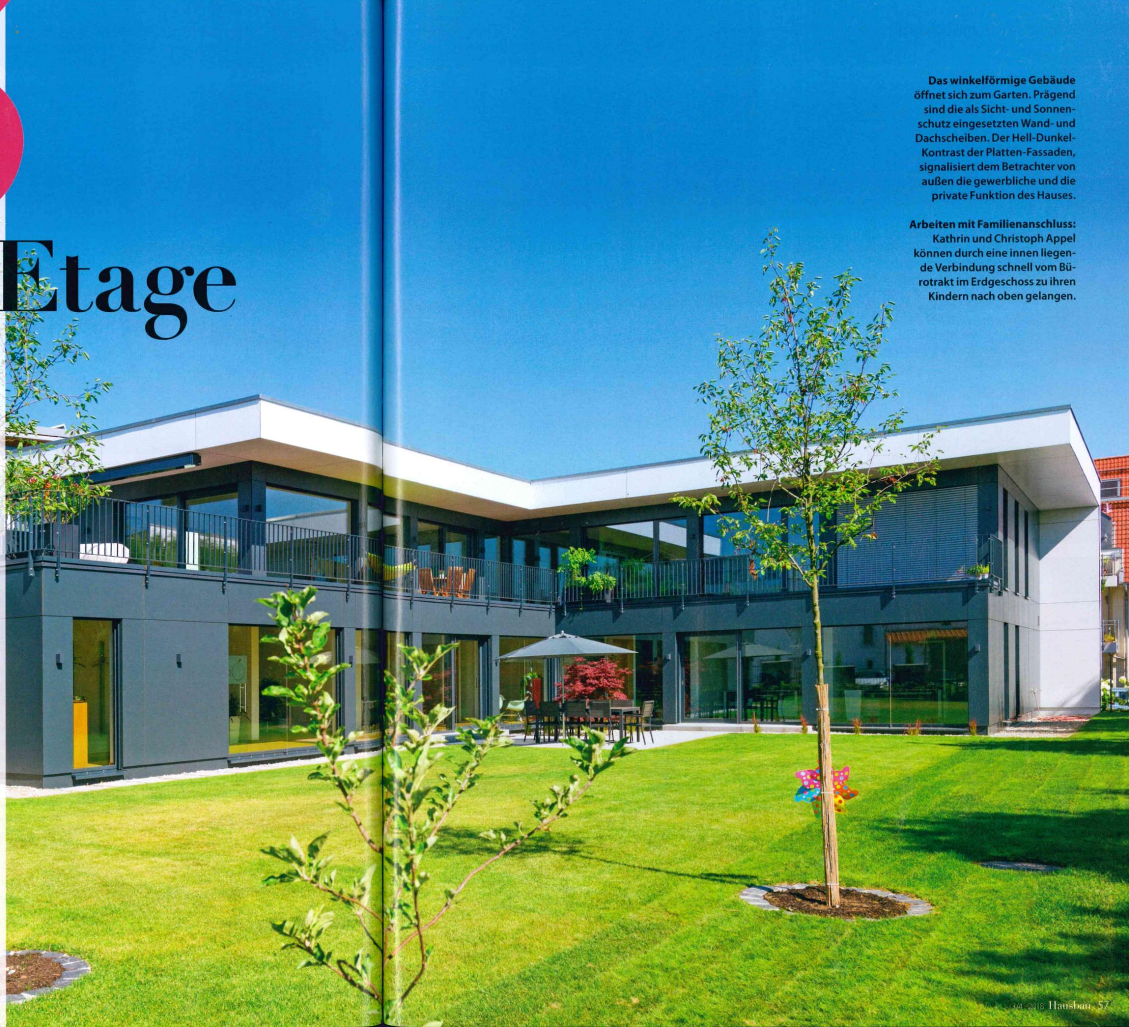
Das winkelförmige Gebäude öffnet sich zum Garten. Prägend sind die als Sicht- und Sonnenschutz eingesetzten Wand- und Dachscheiben. Der Hell-Dunkel-Kontrast der Platten-Fassaden, signalisiert dem Betrachter von außen die gewerbliche und die private Funktion des Hauses.
